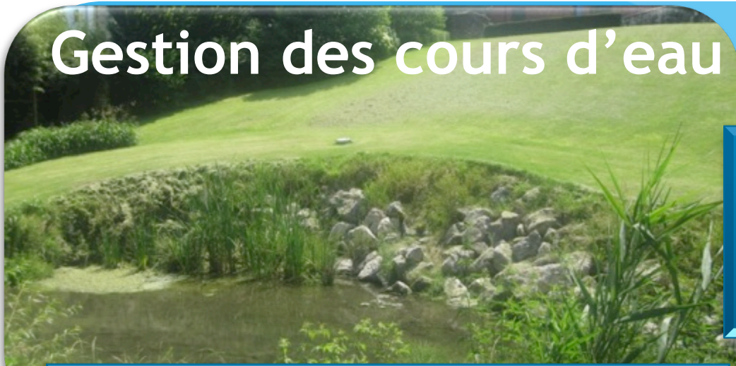
Protection de berges : enrochement
