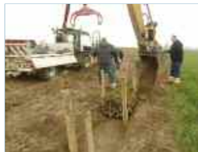
Ouvriers communaux en train de mettre en place les premiers pieux et fagots.
