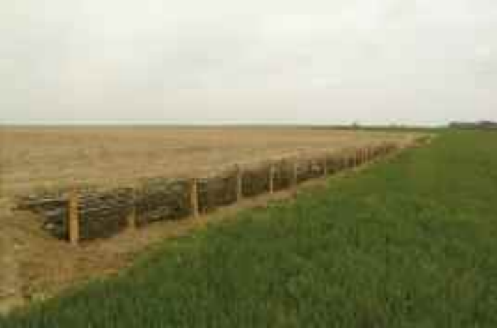
Aperçu d'une fascine morte se trouvant sur les hauteurs de la rue Brigadier L. Mélard.
