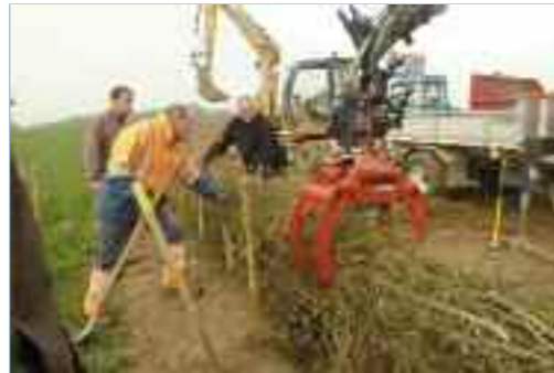
Mise en place des fagots par les ouvriers communaux.
